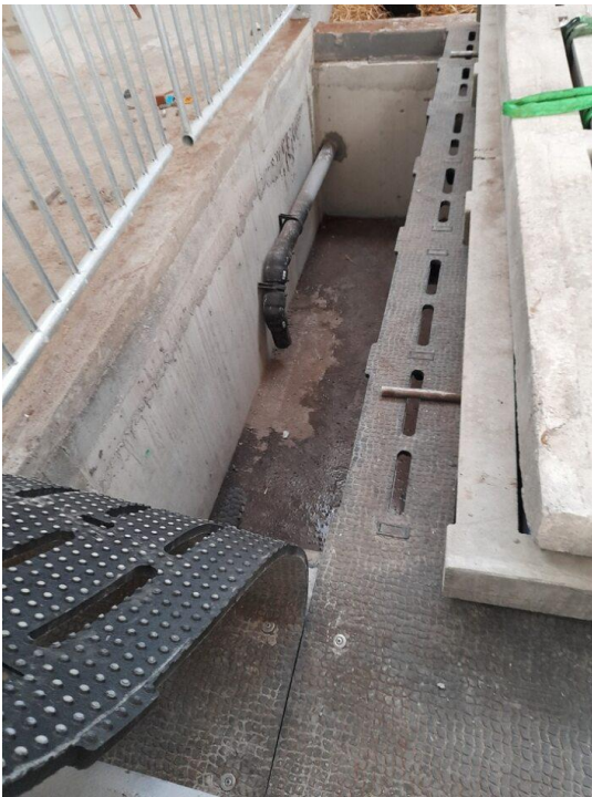
Kuva 3. Pumppausputken pään sijainti kuilussa umpiosaston päädyssä.
