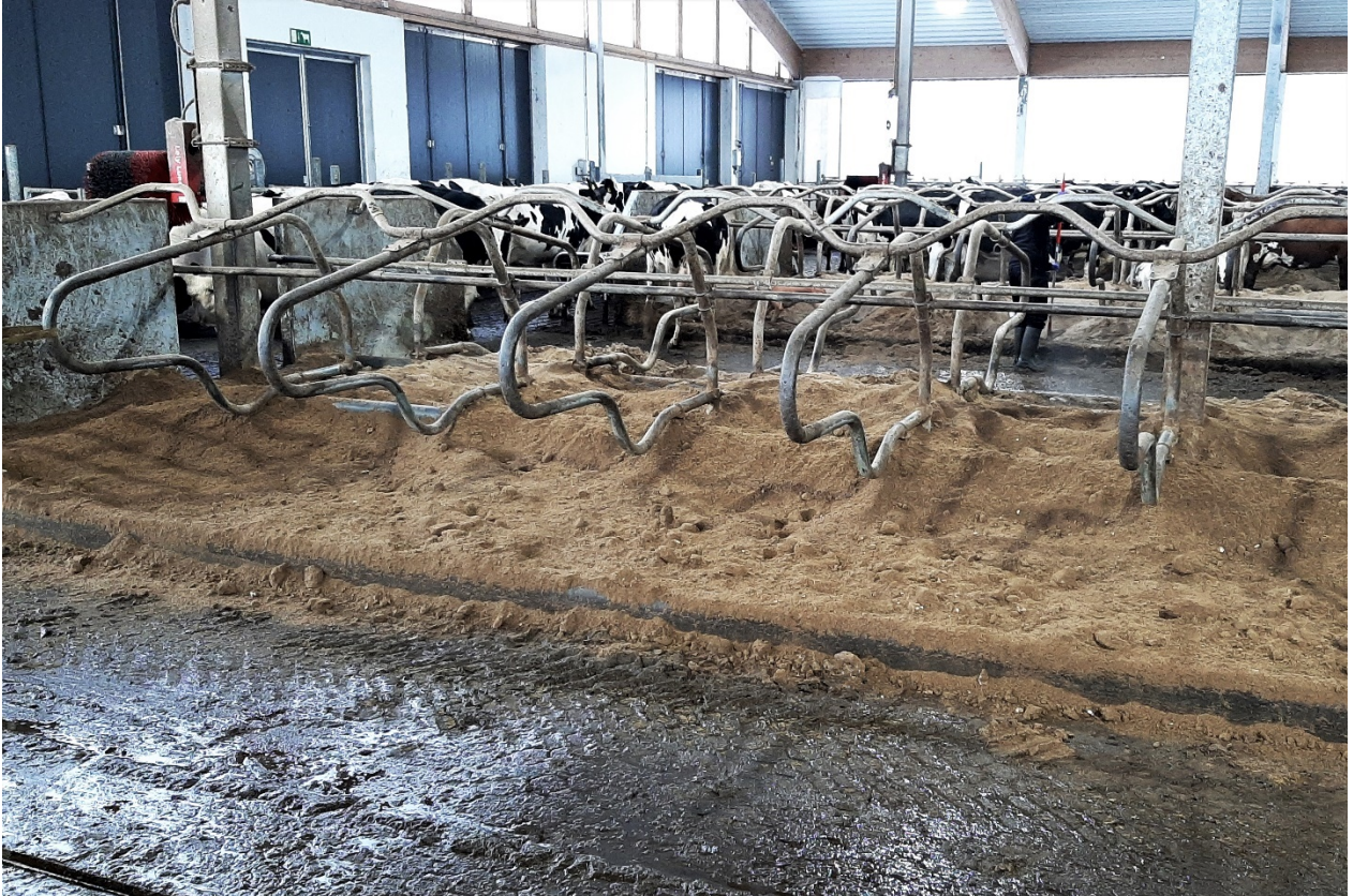
KUVA 22. Hiekkaa kulkeutuu lehmien liikehännän vuoksi lantakäytävälle (kuva: Sari Kolehmainen)
